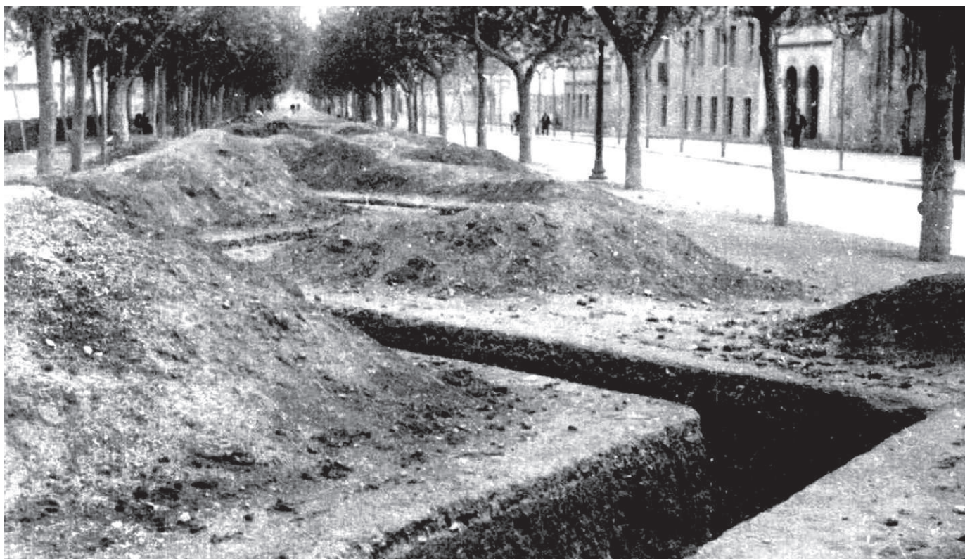
Igualada, abril 1938. Passeig Verdaguier, alçada carrer de Sant Josep. Refugis de trinxera.
