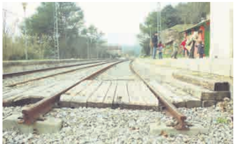
Estació de Rajadell. 2004.
