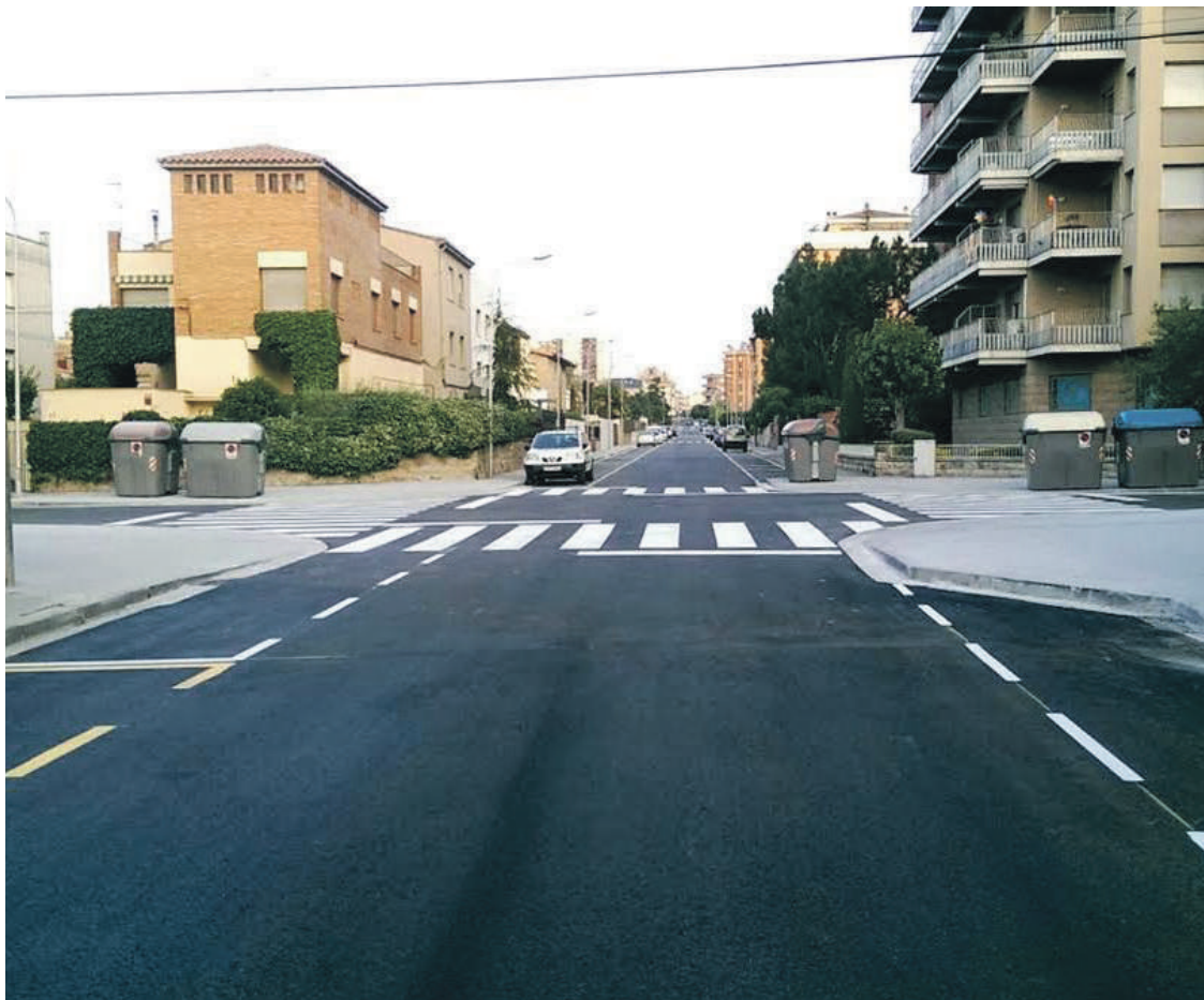
Les obres han inclòs el reasfaltat de tot el carrer, i la millora de les voreres a les cantonades.
