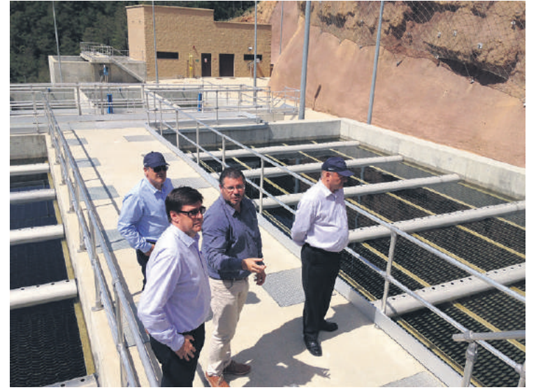
El director de l'ACA ha visitat aquesta setmana les obres per integrar la xarxa a les canonades existents.
