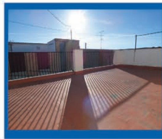
REF. 88712 CASA 5 HAB, CALEFACCIÓ
