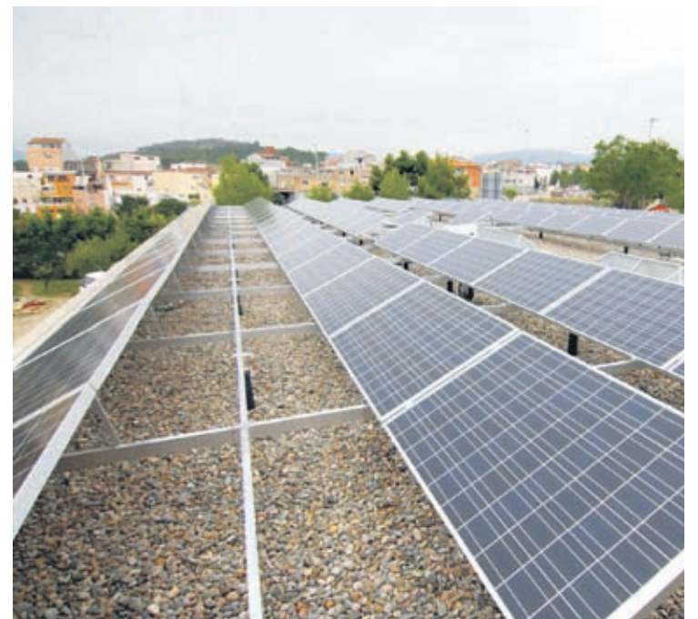
Una de les sis instal·lacions fotovoltaïques municipals.
