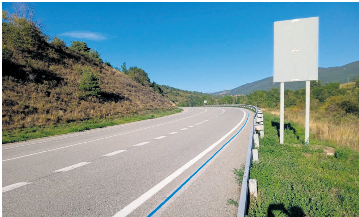
El desplegament de la fibra òptica pública a les carreteres catalanes, marcat amb una línia blava a l'asfalt
